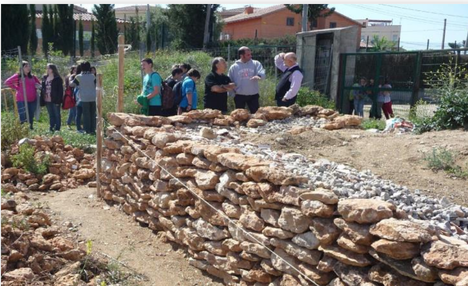
Vista d'una part del marge amb pedra seca que fan els alumnes de l'Institut de l'Arboç
