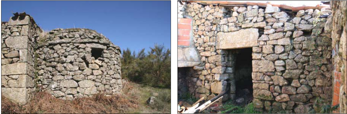
Chozo situada en el confín meridional del término de Navasfrías adosada a una vivienda a la que se accede por la misma.
