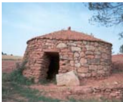
Barraca rehabilitada del Bages Foto Arxiu
