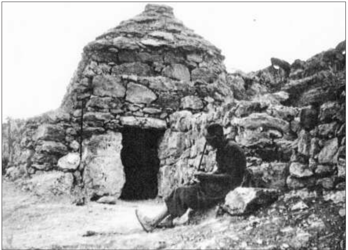
La última barraca de pedra seca feta al Garraf. Fou construïda per Vicens Casanova Querol el 1954, per l'edificació de la Creu de Sant Isidre, al Puig d'en Boronet de Sitges
