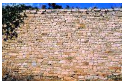
Mur de contenció d'era. Les Aluges
