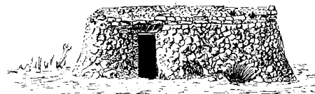
Barraca d'Es Milia Gran (Ses Salines) Mallorca. En su interior encontramos fogar, cisterna y despensa.
