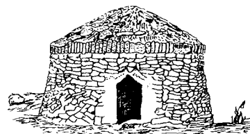
Barraca del Bosc Vall (Petro, Mallorca). Es de planta circular y está techada con piedra y tierra.
